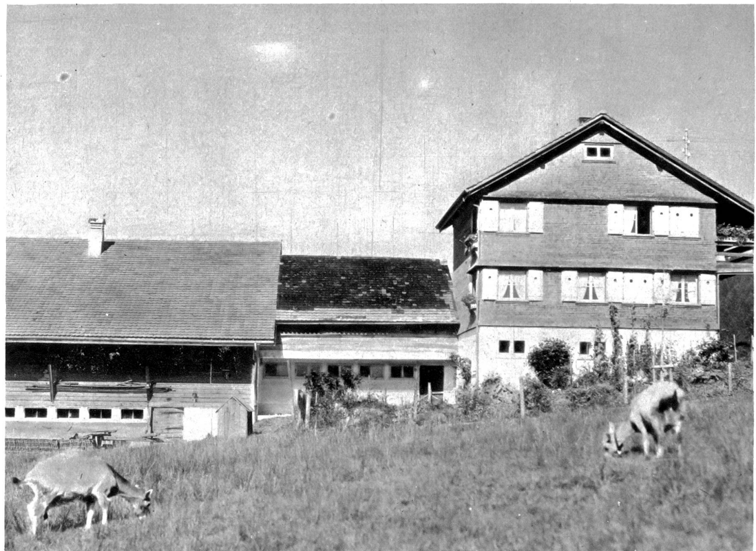
Die Bundesbahnen mussten als Ersatz für unter Wasser gesetzte Häuser viele Bauerngüter neu erstellen. Eines der markanten Schwyzerhäuser
