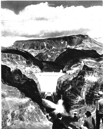
Der Boulder-Damm, der den Colorado abriegelt. Die gestaute Wassermenge — 246 Milliarden Kubikmeter — speist die Kanäle und wird gleichzeitig zum Betreiben eines Kraftwerkes benutzt.
