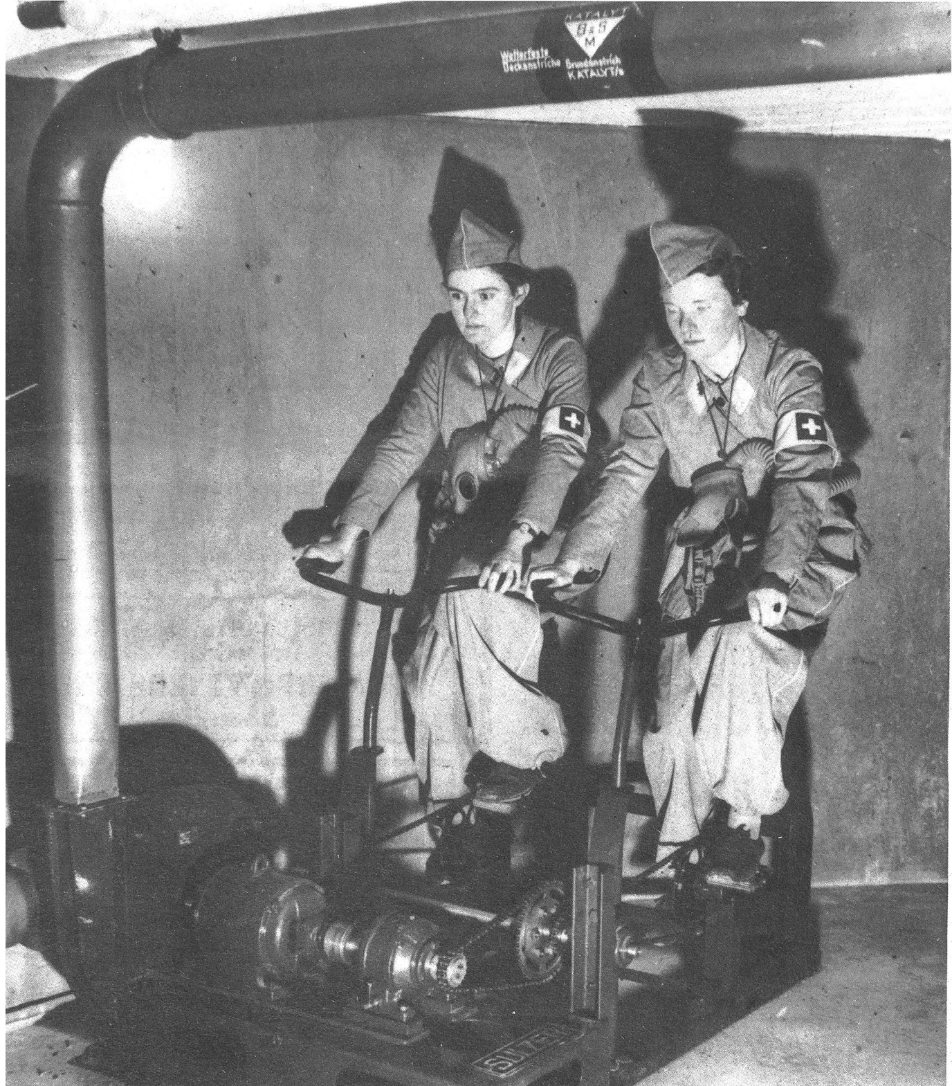
Weibliche Luftschutzwachen in einem unterirdisch angelegten Haus in der Schweiz. In der Schweiz wurden erstmalig Versuche mit einem unterirdischen Haus angestellt, das bei Gefahr von Luftangriffen bezogen wird. Das Haus, das 15 Meter tief in den Boden gebaut ist und eine 5 Meter dicke Betondecke trägt, die 300 Kg. schweren Bomben widersteht, verfügt über 3 Stockwerke, die sämtliche durch ein elektrisches Pumpensystem mit gereinigter Frischluft versehen werden können. Falls die Stromzufuhr ausfällt, wird durch fahrradähnliche Apparate mit Pedalen eine mechanische Pumpe betrieben. Die Luftschutzmannschaften dieses Baues bestehen aus jungen Mädchen. Phot. New York Times.
