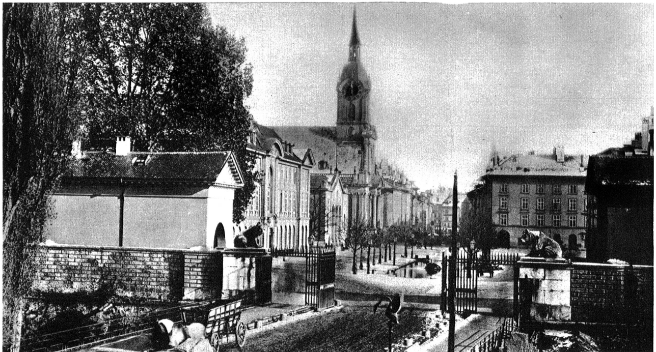
Nach dem Abbruch des alten Murtentores errichtete man an dessen Stelle das Gittertor mit den beiden Zollhäuschen. An Stelle des Walles neben dem Burgerspital (im Bilde links) entstand an der heutigen Bogenschützenstrasse eine Promenade mit einem Schwanenteich.
