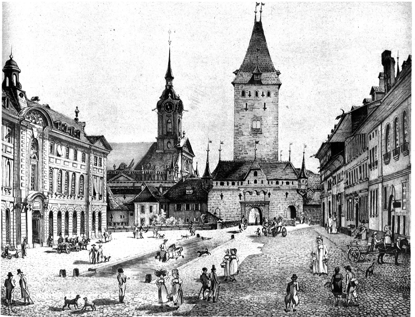
Blick auf den Platz „zwischen den Toren“ in den Jahren 1820–1825. Am Christoffelturm zeigen sich die ersten Spuren des Verkehrszeitalters: südlich neben dem seit 1346 einzigen und genügenden Toreingang wird 1820 ein zweiter für Fussgänger durchgebrochen (zweiter Durchgang im Bilde rechts).
