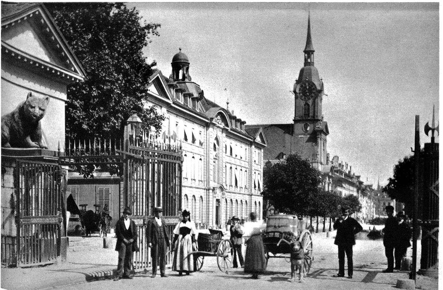
1880 musste auch dieses Tor dem Verkehr weichen. Die beiden das Tor hütenden Bären aus Granit, die 1825 aufgestellt worden waren, kamen vorerst zum Aarbergertor, und —als auch dieses abgerissen wurde— im Jahre 1895 vor das Historische Museum, wo sie noch heute der verschwundenen Herrlichkeit nachtrauern.
