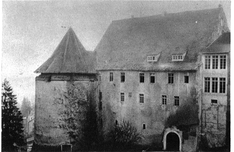
Tour du coq (Hahenturm) am Ostende des Schlosses, aus dem 14. Jahrh. stammend.
