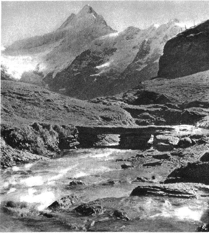
Primitive Steinbrücke aus grossen Platten. „Steinbrigg“ über den Mühle-Bach bei Grindelwald. Im Hintergrund das Schreckhorn und der Ober-Grindelwaldgletscher.
