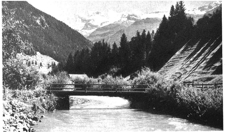
Einfacher Steg aus behauenen Stämmen. Kiental, im Hintergrund die Blümlisalp. Phot. Gyger.
