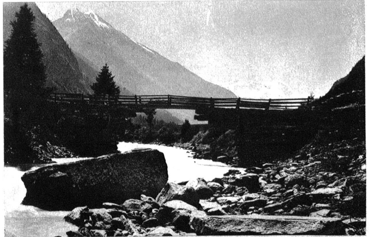
Brücke auf Endpfählern ruhend, die aus überragenden Stämmen aufgebaut sind. Brücke bei Randa im Zermattetal. Im Hintergrund das Breithorn.
