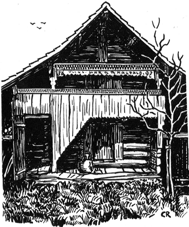
Abb. 6. Speicher aus dem Jahre 1697. Oberspach bei Ranflüh. Die Laube hat noch keine Ausschnitte. Hingegen sind das Spruchbrett und die Balken mit Farbe verziert.
