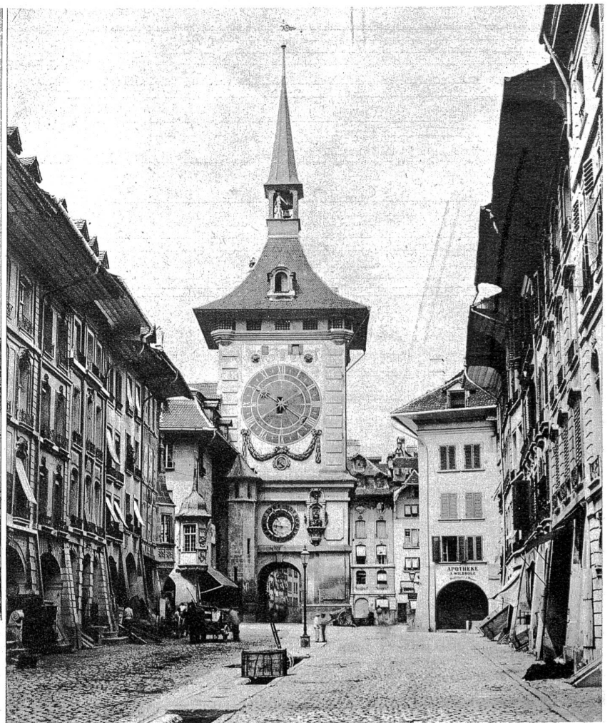
Die Ostfassade mit der Darstellung der vier Lebensalter, nach der Restauration und Neubemalung von 1892
