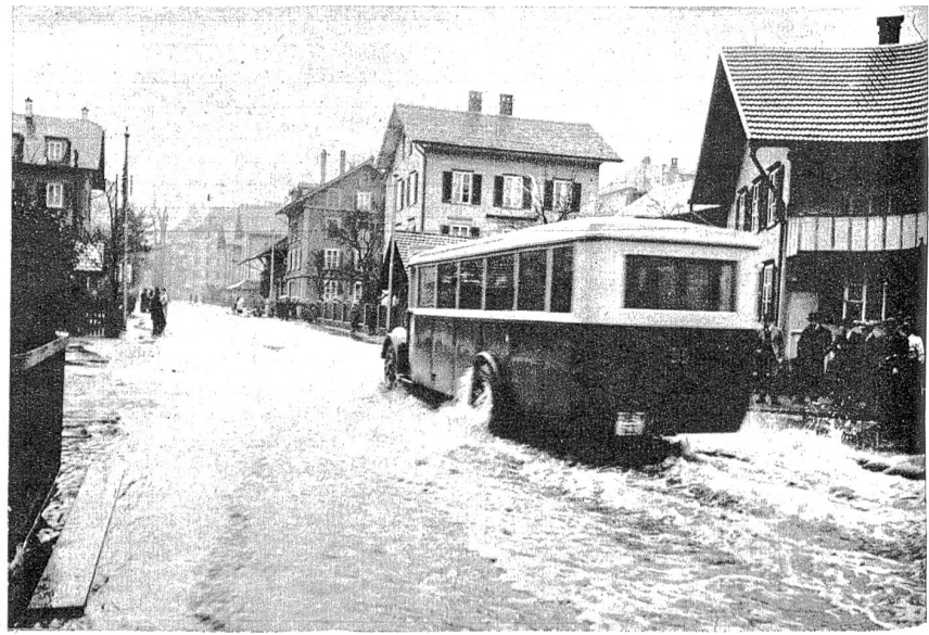
Die Tramgeleise sind mit Kies und Sand ausgefüllt. Stadtbusse müssen den Verkehr aufrechterhalten, da die Tramwagen nicht mehr fahren können. (Photo K. Müller)
