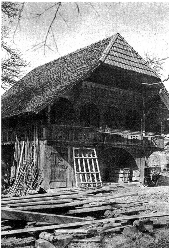
Speicher Lüthi vor der Instandstellung.
