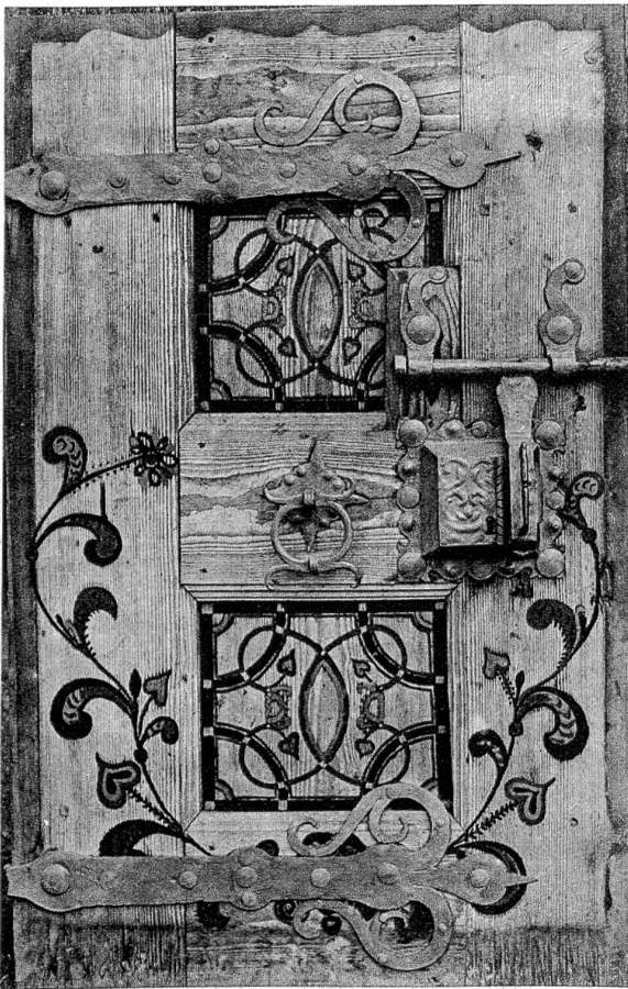
Speicher Fankhauser: Türe des obersten Stockes.
