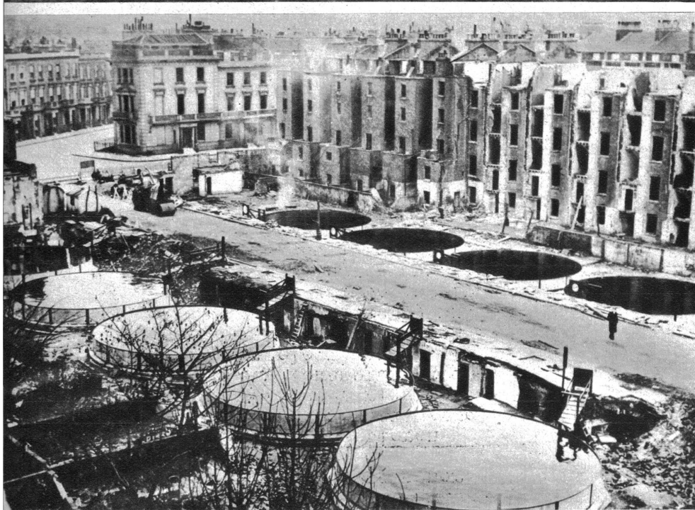
Links: Riesen-Wasserbassins aus Fundamenten bombardierter Londoner Häuser! In verschiedenen Quartieren Londons sind in den Fundamenten bombardierter Häuser riesige Wasserbassins zur Bekämpfung grosser Brände angelegt worden. Unser Bild zeigt einige noch im Bau befindliche (rechts) und einige bereits gefüllte Bassins in einem niedergelegten Quartier (Photopress)
