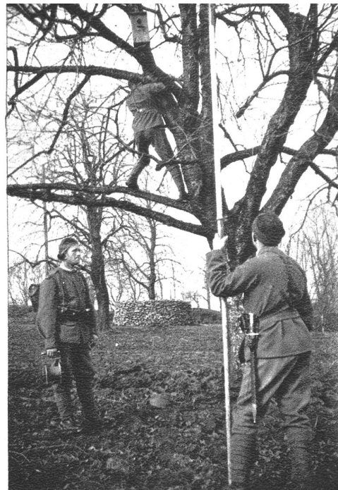
Unterwegs auf dem Linienbau. Dieses Bild veranschaulicht einen kleinen Ausschnitt der Tätigkeit wie sie öfters vorkommt. Der Mann auf dem Baum macht sich daran, den Draht zu oberst im Geäst mit einem sogenannten „Mastwurf“ zu befestigen. Nur wenn die Linie hoch genug hängt, braucht man bei längeren Spannungen nicht zu befürchten, dass der Draht im Manövergelände von den Truppen zerrissen wird.
