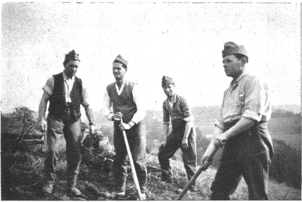
Eine Gruppe sticht Rasenziegel, um sie an einer Stelle zu verwenden, wo infolge Errichtung irgend einer Anlage die Erde blossgelegt werden musste. Kein Mensch wird da nachher etwas „Unnatürliches“ vermuten.
