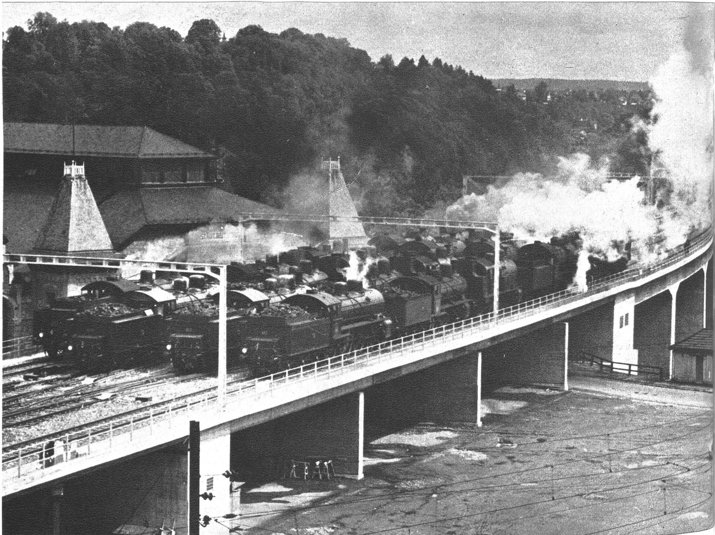
Das Verhalten der Brücke bei der Belastungsprobe wurde an acht verschiedenen Punkten mit grösster Sorgfalt und mit besten Instrumenten gemessen. Auch die Spannung im Brückeninnern wurde mit Präzisionsprüfern vorgenommen. Der die Vermessungsarbeiten leitende Ingenieur teilte mit, dass die praktisch gewonnenen Resultate den Vorberechnungen entsprechen.
