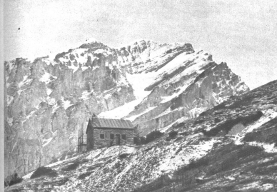
Frühen. Die neue Balmhorn-Wildseigenhütte der Sektion „Alteis“ des Schweizerischen Alpenklubs erbaute und unlängst eingeweihte neue Balmhorn-Wildseigenhütte liegt südlich des Gastrotals, oberhalb der wilden Felsflanke, auf einem kleinen grünen Plateau, genannt Wildseigen, am Fusse des Balmhorn-Nordgrates, in einer Meereshöhe von 1961 m. Die Hütte enthält im Erdgeschoss ein allgemeiner Aufenthaltsraum für 26 Personen, Küche, 1 kleines Zimmer für den Hüttenwart und eine Schlafpritsche für 6 Touristen. Der 1. Stock ist in zwei Schlafräume mit zusammen 20 Schlafplätzen unterteilt. Bauleiter war Herr O. Fahrni, Architekt, S. I. A., Thun. G. L., J.
