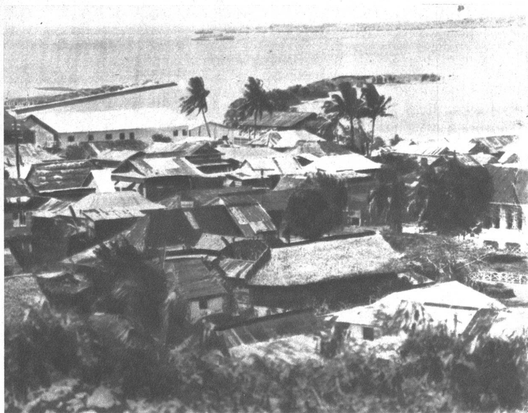
Ansicht von der Insel Guam, des vorgeschobenen amerikanischen Flottenstützpunktes im Pazifik, dessen Besetzung die Japaner meldeten
