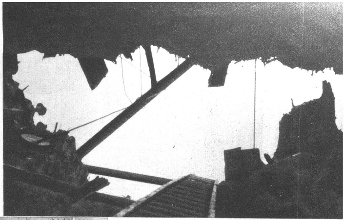
Rechts: Ausblick aus der Tiefe des Reparaturstollens. Das ist alles, was die Arbeiter tagsüber sehen
