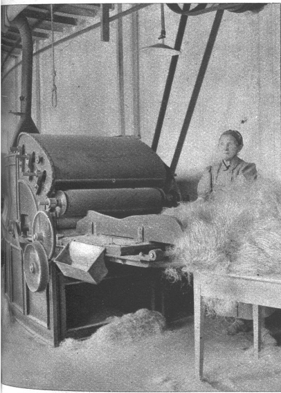
In dieser langen Maschine wird das Pferdehaar aufbereitet, bevor es in die Spinnerei kommt
