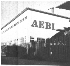
Die Anlagen der Maschinenfabrik umfassen ein ansehnliches Areal, baulich der modernste Teil ist die Schreinerei
