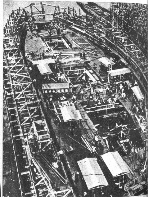
5. Tag. Nach der Kiellegung bringen Tausende von Arbeitern bereits fertige Schiffsteile an Ort und Stelle, so dass man das Schiff buchstäblich wachsen sieht
