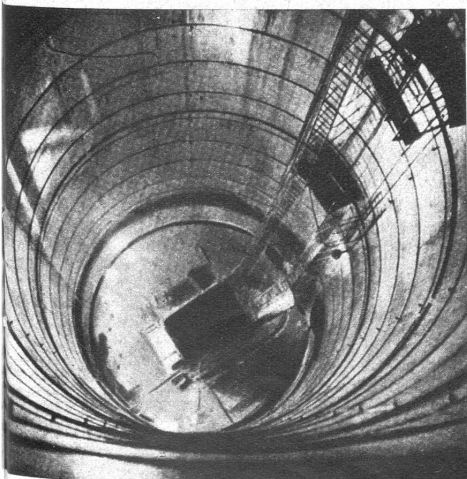
Abb. 3. Der 60 m tiefe und 8,50 m weite, gepanzerte Vertikalschacht. Abb. 4. Standseilbahn
