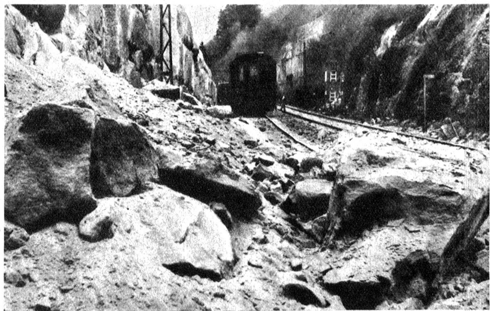
Zugsentgleisung auf der Linie Freiburg—Bern
