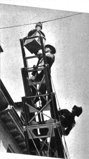
lampe zu demonstrieren. So mussten also Spezialisten geholt werden. Nach einer Viertelstunde erschien der Picketwagen des EWB prompt am Ort der Handlung. Mit vereinten Kräften gelang es dann, die von Tausenden von Bienen umschwärmte Lampe auf den Boden zu bringen und so wenigstens einen Teil der Ausflüger wieder in sicheren Gewahrsam zu nehmen. Reporter Eugen Thierstein
