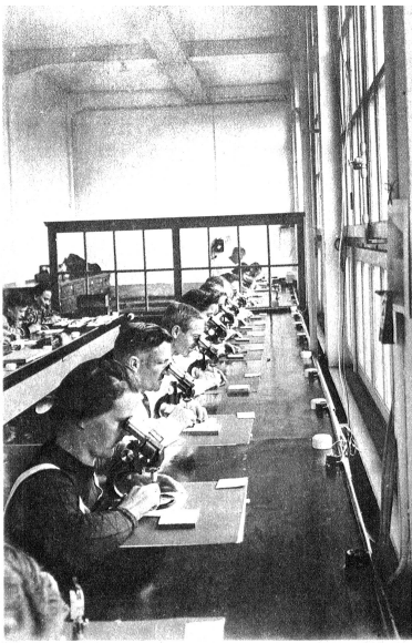
Die Kontrolle der Steine wird sorgfältig mit Zeiss-Mikroskopen vorgenommen Unten: Das Polieren der gewählten und abgerundeten Flächen der Steine erfordert nur gut geschultes und erfahrenes Personal
