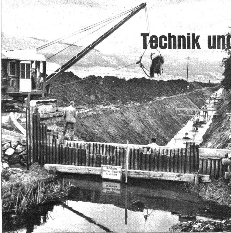
Ueberblick über die Baustelle
