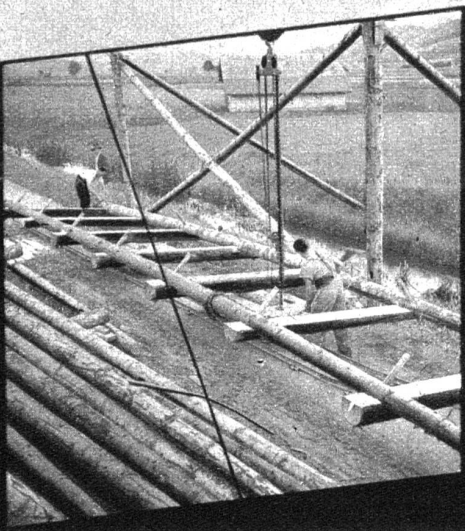
Fertig abgebundener Holzeinbau mit Verladeeinrichtung
