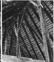
Links: «Althaus»-Einzelheiten. Der ganze mächtige Bau ruht auf gewolligen, verzäpften Eichenschwellen. Laubeläden und Fenstergerüste sind reich geschnitzt - Rechts: Heubühne des Althaus. Konstruktion eines Hochstuhls.
