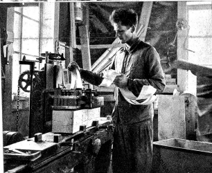
Die Maschine hobelt aus einem Trümel Holzspäne jeder gewünschten Breite und Dicke
