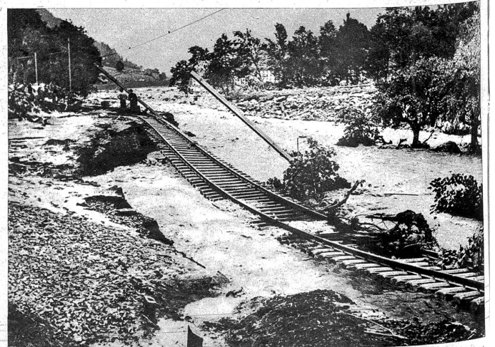
Die Verwüstungen im Glarnerland durch das Unwetter der letzten Woche. Die unterspülte Linie nach Linthal.
