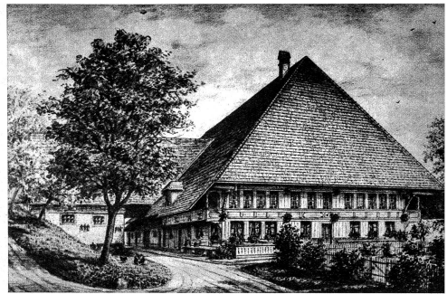
Prächtiges Emmentaler Bauernhaus in Brechershäusern, Wynigen, erbaut im Jahre 1773. Die schönen, ausgeprägten Baupropportionen und der wichtige Gerschild sind besonders bemerkenswert
