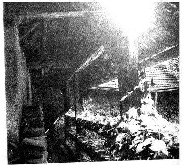
Wehrgang in der Stadtmauer
