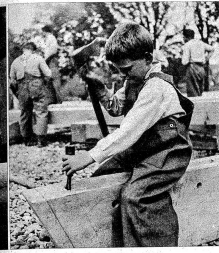
Früh übt sich, was ein Meister werden will. Dieser Junge hat heute schon Gelegenheit, Proben seines Könnens abzulegen. Seine Aufgabe ist, Zapfenlöcher in die Balken zu hauen
