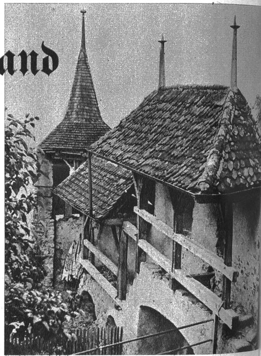
Von der Kapelle bei der Kirche, zieht sich die Ringmauer mit Wehrgang und vielseitigen Spitztürmen um das Städtchen
