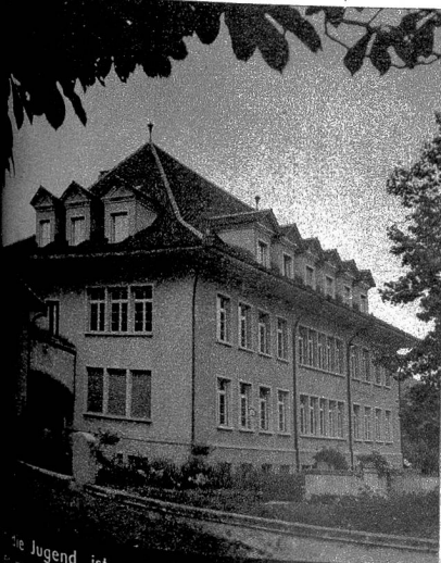
Die Jugend ist nur das Beste gut genug. So war der Leitspruch beim Bau des schönen neuen Schulhauses von Stettlen
