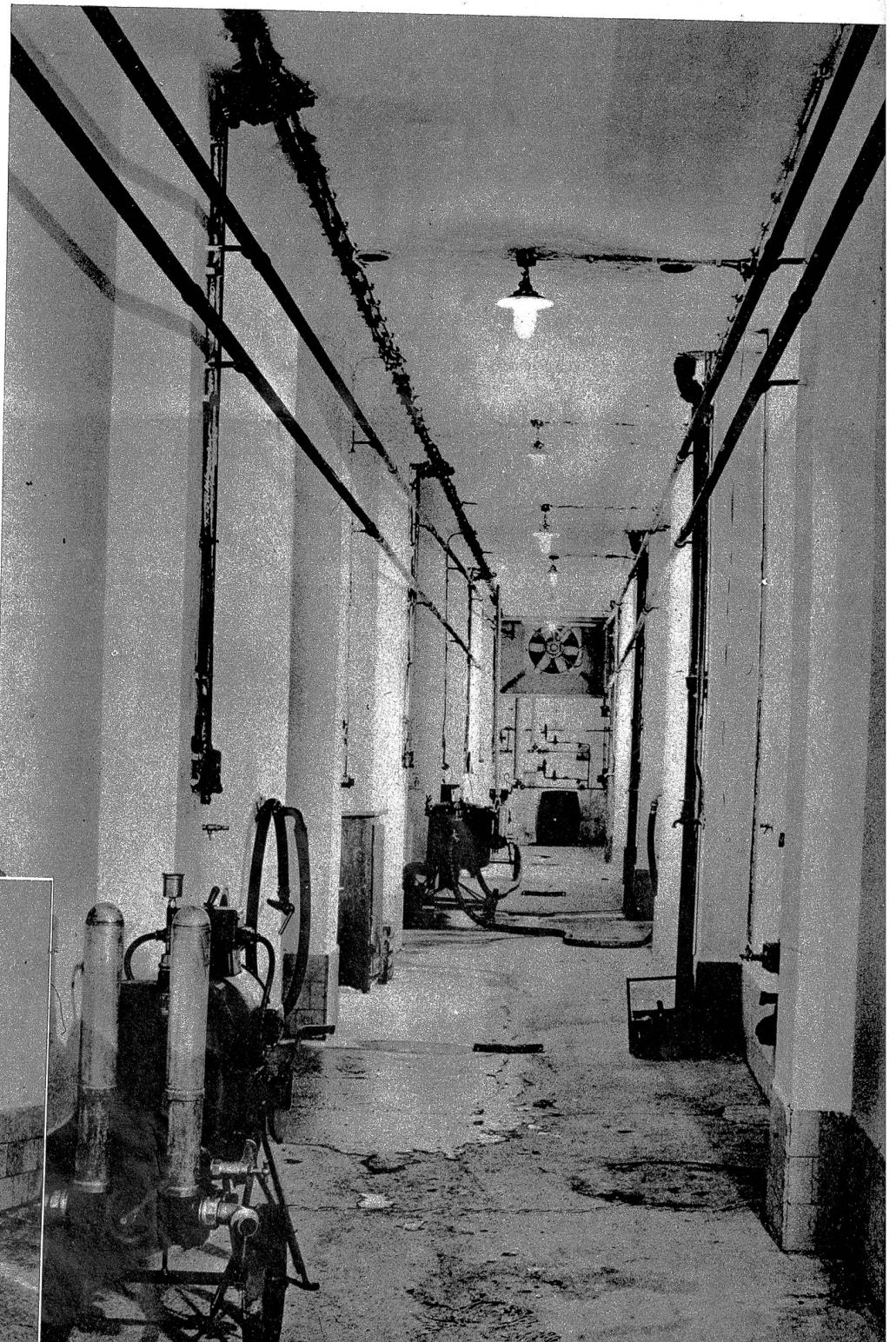
Kompressoren zur Kühlanlage
