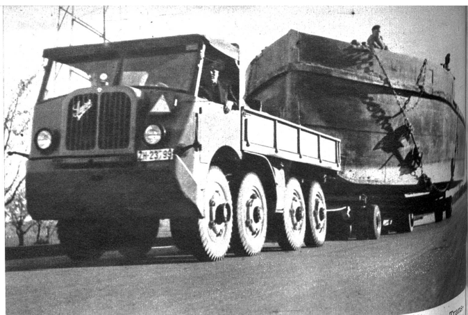
Ein ungewöhnlicher Transport hat dieser Tage die Aufmerksamkeit des Publikums zwischen Lausanne und Luzern erregt. Das 20-Tonnen-Lastschiff «Bour» war in Ouchy aus dem Genfersee gehoben, in zwei Hälften geteilt und mittels Autozug über Murten-Ölten Vierwaldstättersee führt worden. Unser Bild zeigt die vordere Hälfte des Lastschiffes auf seiner gewöhnlichen Reise. (Photopress)
