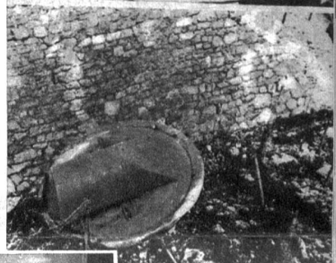
Oben: Die Verschaltung eines Panzerturms, dessen Kuppel durch die Explosion weggeschleudert wurde. — Unten: Kuppelaufbau des Panzerturms, welcher mit dem Geschütz einige Dutzend Meter vom Standort weggeschleudert wurde. (ATP)
