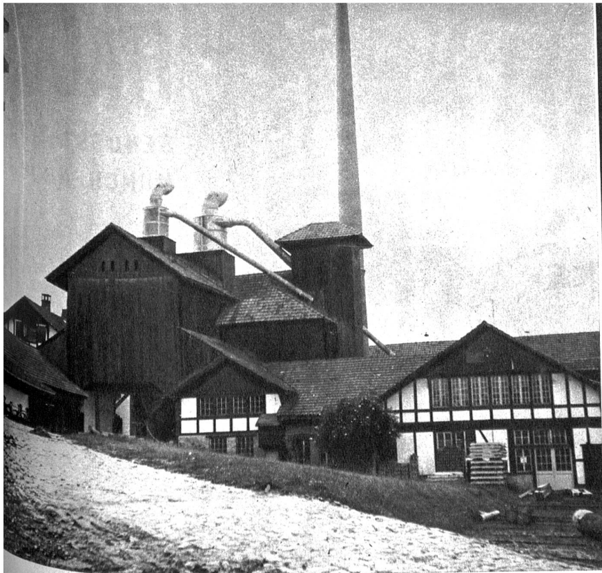
Die moderne Siloanlage
