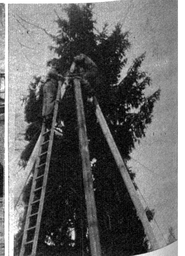
Mit einem Dreibock und einem Flaschenzug wurde die Tanne aufgezogen
