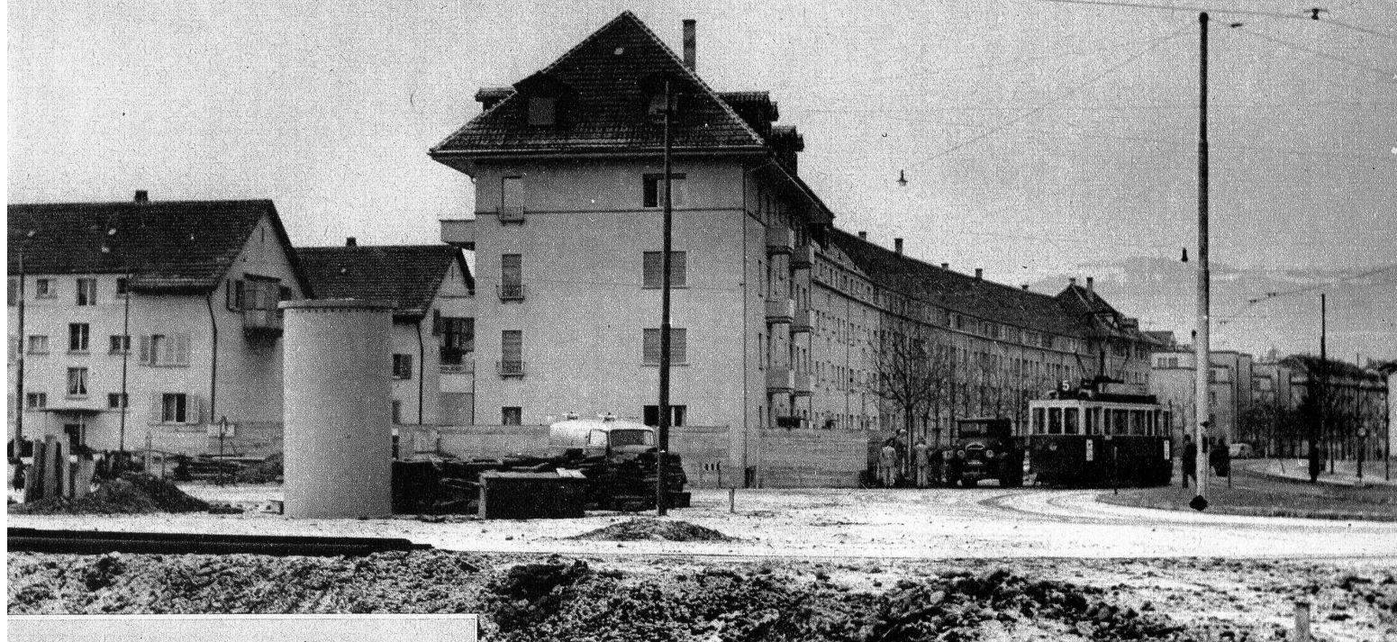
Die Häuserreihe am Ostring mit den äussersten Bauten Nr. 58—62 (links vom Tramzug), die Senkungerscheinungen aufweisen. Auf unserm Bild steht die Plakatsäule des EWB allerdings bedeutend schiefere als die Häuser
