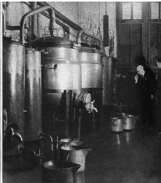
Die Brennereianlage mit 4 Destillierblasen
