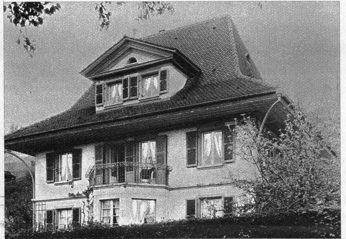
Wohn- und Geschäftshaus der Firma Fritz Stämpfli in Langnau
