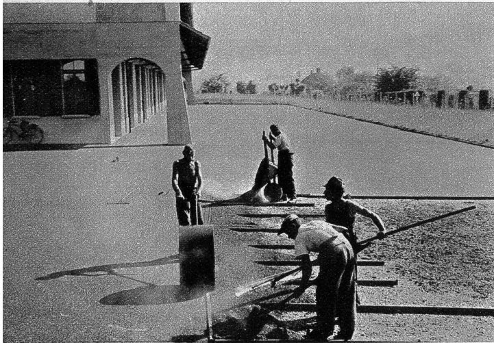
Einbau von Teer-Asphalt-Belag vor einem Zeughaus
