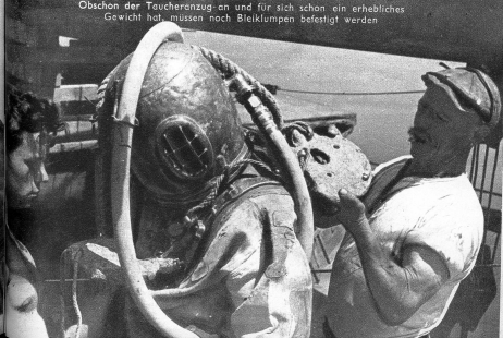
Obwohl der Taucherganzung und für sich schon ein erhebliches Gewicht hat, müssen noch Bleiklumpen befestigt werden
