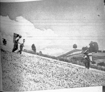
Unten: Traktoren kennt man nicht im Eriz. Man macht es noch von Hand! Aber im ganzen Emmental hat sich der Seilzug eingebürgert. Hier haben wir ein Beispiel vom Ersatz eines Motors durch Menschenkraft. Wer abwärts geht, zieht am Seil den aufwärts Gehenden empor.
