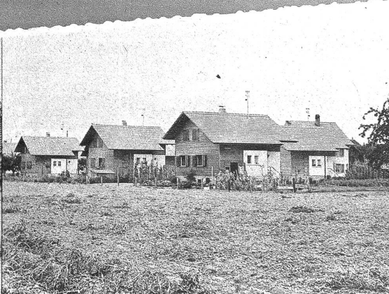
Neue Wohnsiedlung in Oberdorf
