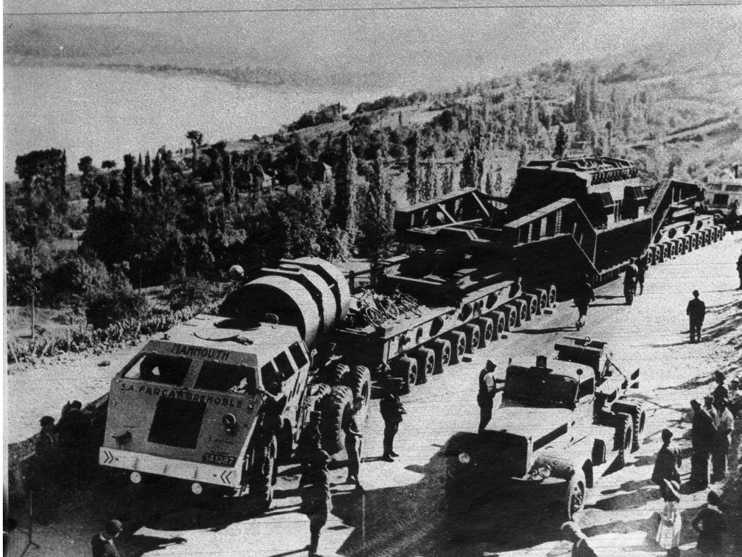
Das Elektrizitätswerk von Genissiat an der Rhone in Frankreich, eines der grössten in Europa, geht langsam seiner Vollendung entgegen. Dieser Tage ist ein gigantischer Transformator im Gewicht von 300 Tonnen auf Spezialwagen mit 96 Rädern in den Tunnel des Mont du Chat transportiert worden
