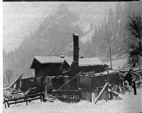
Das Haus der Frau Hari in Mitholz ist vollständig ausgebrannt. Im Hintergrund oben die Ruine Felsenburg, die von der Lötschbergbahn umfahren wird
