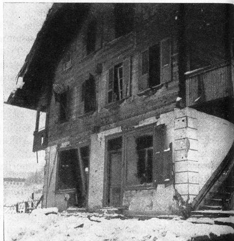
Wie im Kriege... das Haus mit dem Konsumladen, dessen sämtliche Fenster eingedrückt wurden, mit demolierten Rahmen und voller Geschosstreffer (Photo Trachsel)
