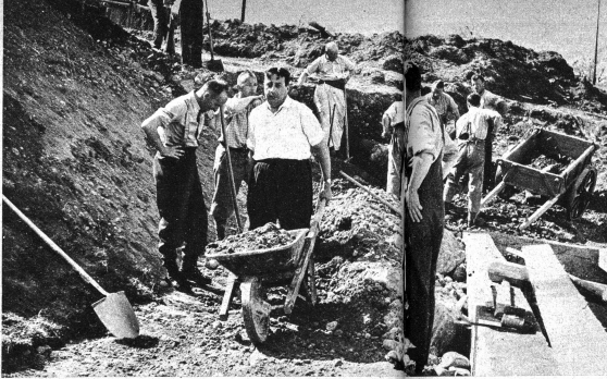
Auffüllarbeiten zwischen Scheibenstand und Kugelfang. Die Arbeitsgruppe im Vordergrund besteht aus lauten Geistesarbeitern die sich aber nicht minder kräftig ins Zeug legen
