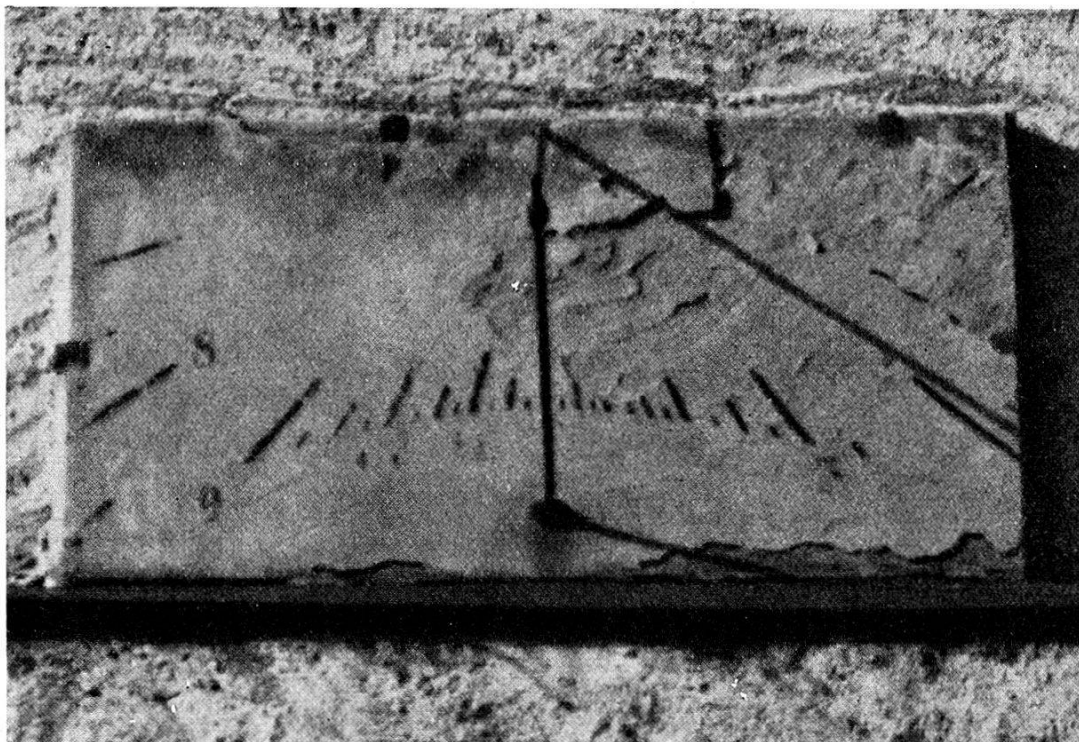
Fig. 2. Wahre Zeit zeigende Sonnenuhr im Zerkindenhof zu Basel. Aufnahme von H. H. Zweifel 1942. Länge und Breite der Steinplatte 145 cm und 84 cm.
