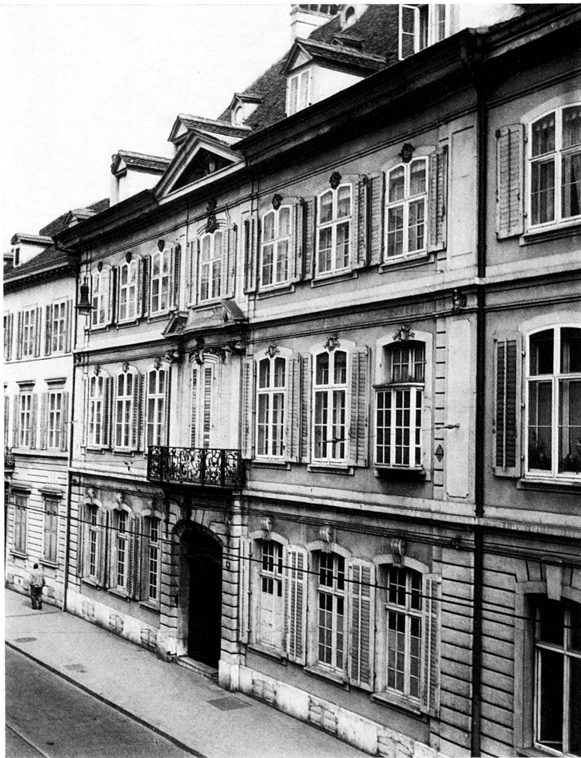
Tafel 27. Haus zum «Raben», Hauptfassade.
