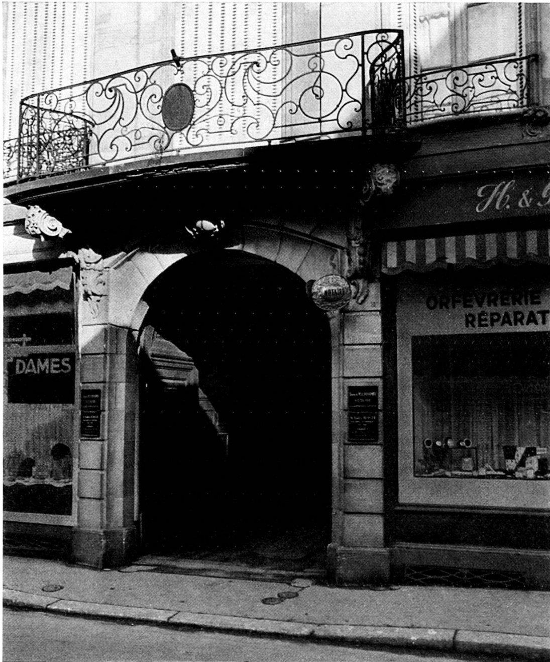
Tafel 4. Haus 7, rue du Dôme, Straßburg.
