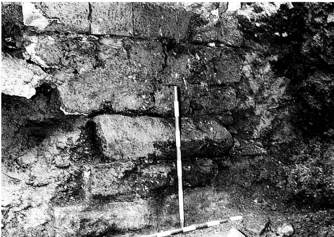
Tafel 6. Greifengasse 2 – Rheinbrücke: – Oben, Bossenquadermauerwerk des Brückenkopfes von 1225, untere Partie. – Unten, Übergangszone mit zurückspringendem Gesims, untere Partie Bossenquader mit Randschlag, obere Partie glatte Steine mit Verputz.
