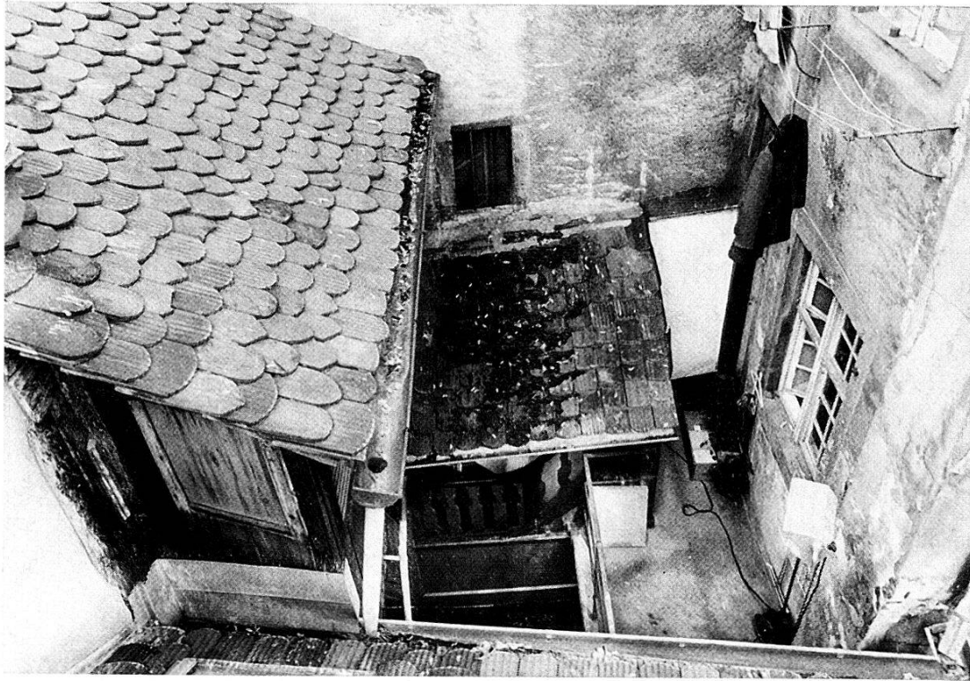
Tafel 12 oben. Petersgasse 52: Blick in den Innenhof mit dem offenen Treppenhaus zwischen dem vorderen und hinteren Wohntrakt.
